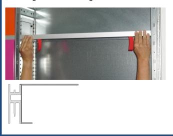
3. Schutzfolie an beiden Enden ca. 50 mm vom Montageband abziehen.
