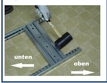
2. Kontrollieren, ob alle 4 Haken der Stabilisierungsplatte eingehängt sind.
