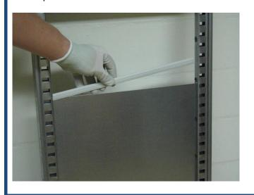
2. Nächstes Element von oben in Plastikprofil stecken.
