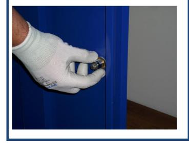
6. Stangen durch die Führungen schieben. Die stärker abgekröpfte Stange ist oben!
