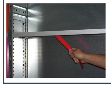
6. Schiene auf ganzer Länge während mehrerer Sekunden mit ca. 5 kg andrücken. Türen erst nach 72 Stunden, beziehungsweise 3 Tagen einhängen. Nur dann kann das Montageband die volle Klebekraft entfalten!
