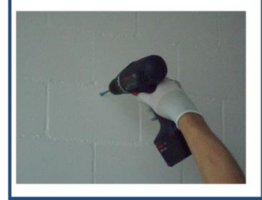
4. Regal an die Wand stellen und Wandbefestigung von oben in den Pfeiler schieben. Schraube fest anziehen. Der Pfeiler selbst wird nicht mit der Wandbefestigung verschraubt.
